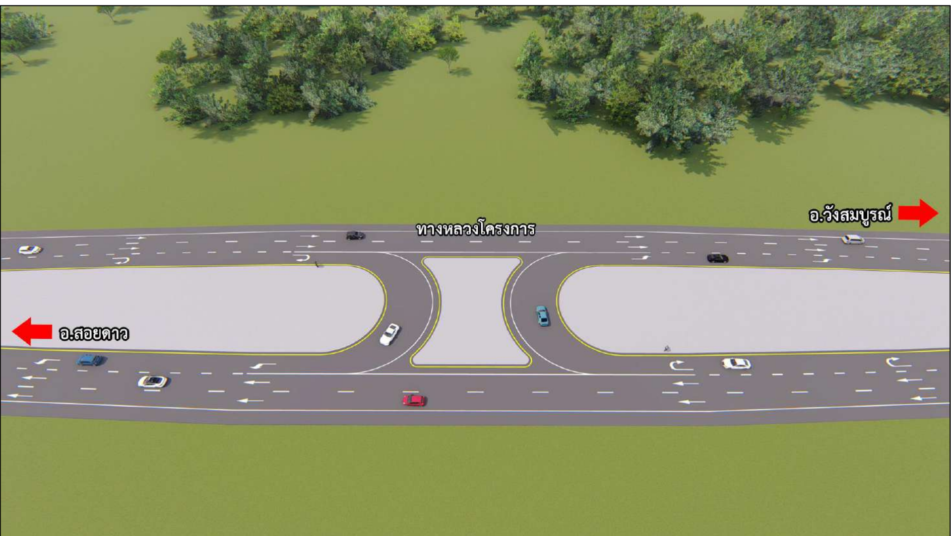
รูปที่ 2.2.1-8 รูปแบบจุดกลับรถแบบเปิดเกาะกลาง
