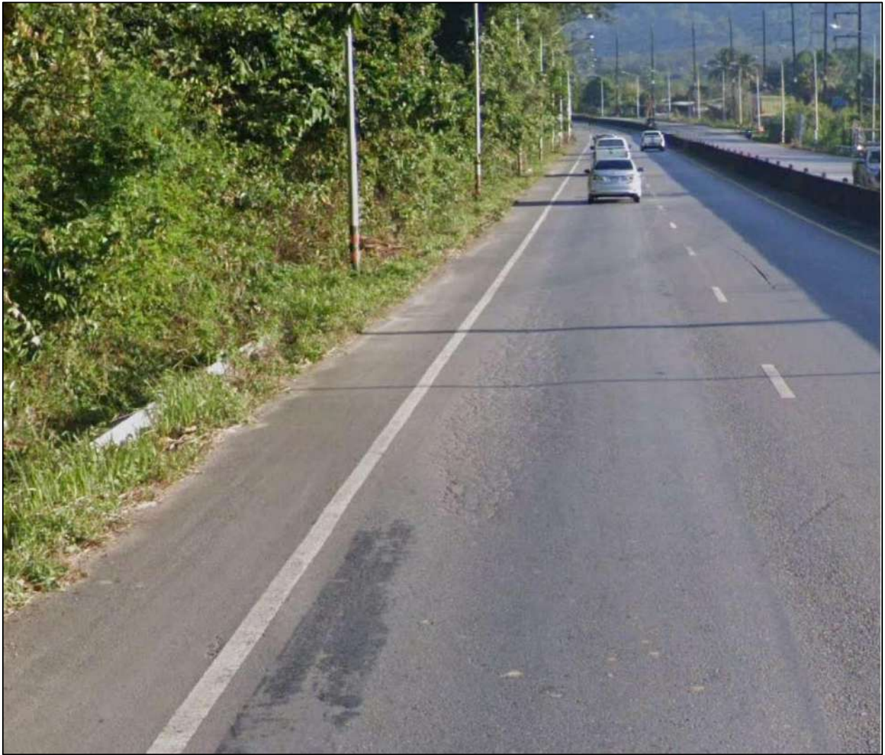
รูปที่ 2.3.4-6 ผิวจราจรชำรุดเสียหายแบบร่องล้อ
