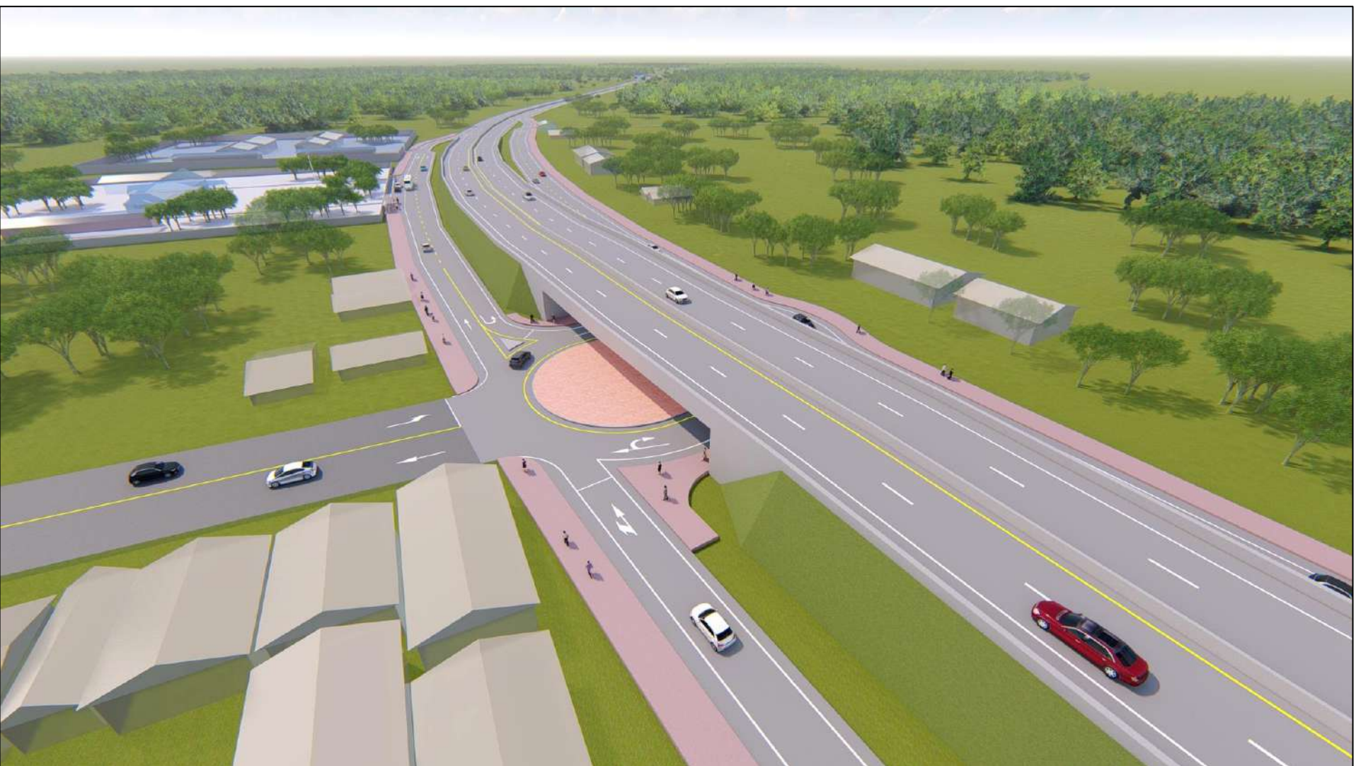
รูปที่ 2.3.7-3 รูปแบบจุดกลับรถและทางแยกแบบสะพานต่างระดับ
