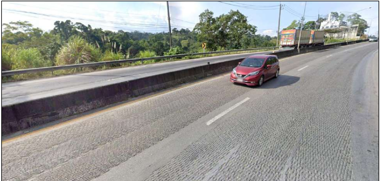
รูปที่ 2.3.4-5 ผิวจราจรแบบทำลาย เพื่อแก้ไขปัญหาการลื่นไถล
